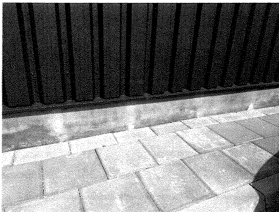
Zdjęcie nr 59. Cokół betonowy na zewnątrz obiektu nr 3b
